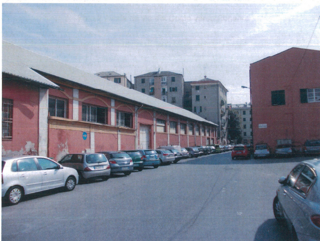
Foto 1 - vista generale da via dei Costo verso via Soliman
